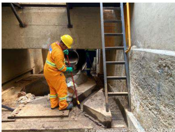
Foto 15 – Retirada de material contaminado de dentro usina. (Data: 08/09/2022)
