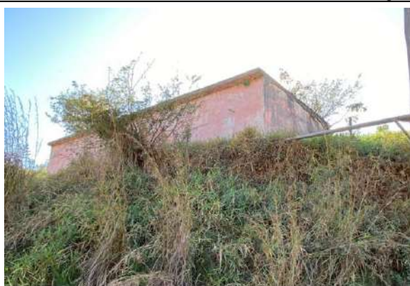
Foto 1 - Vista externa da estrutura
