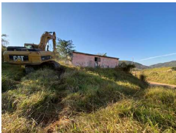
Foto 5 – Início da demolição. (Foto: 29/07/2022)
