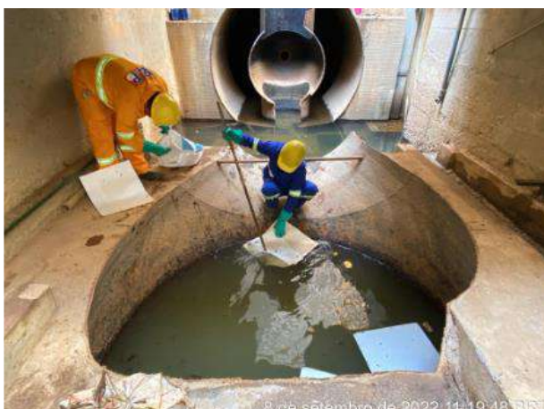
Foto 17 – Retirada de material contaminado de dentro usina. (Data: 08/09/2022)
