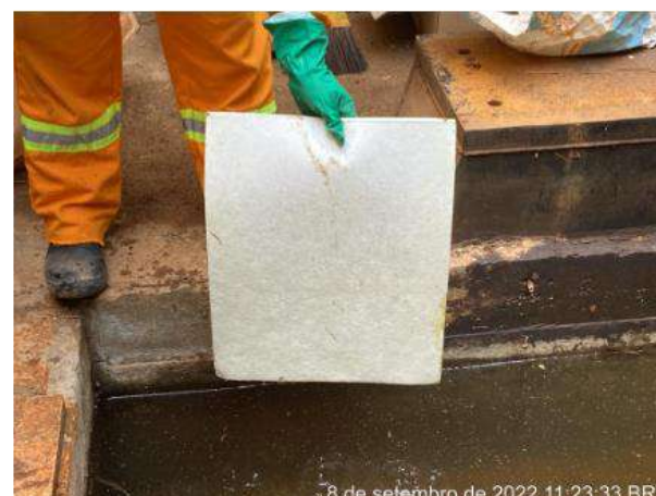
Foto 20 – Retirada de material contaminado de dentro usina. (Data: 08/09/2022)
