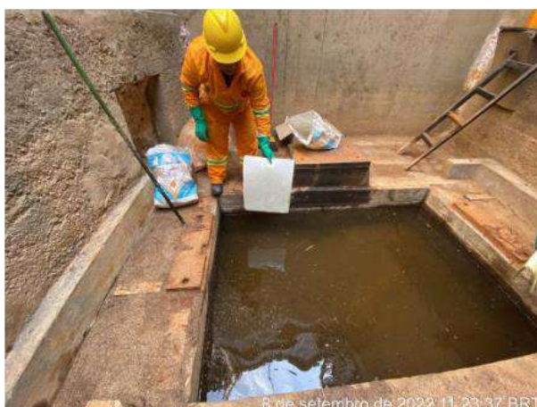
Foto 19 – Retirada de material contaminado de dentro usina. (Data: 08/09/2022)
