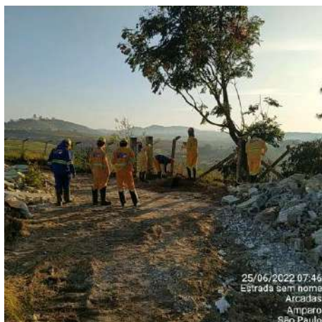
Foto 1 – Início da demolição. (Foto: 26/06/2022)
