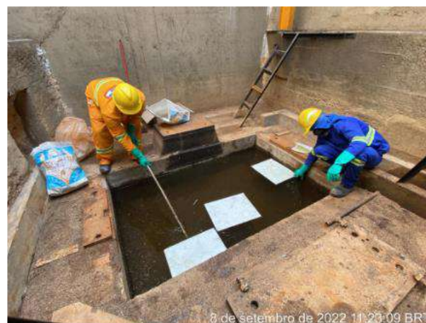
Foto 18 – Retirada de material contaminado de dentro usina. (Data: 08/09/2022)
