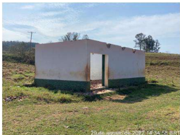
Foto 9 – Início da demolição. (Foto: 29/08/2022)
