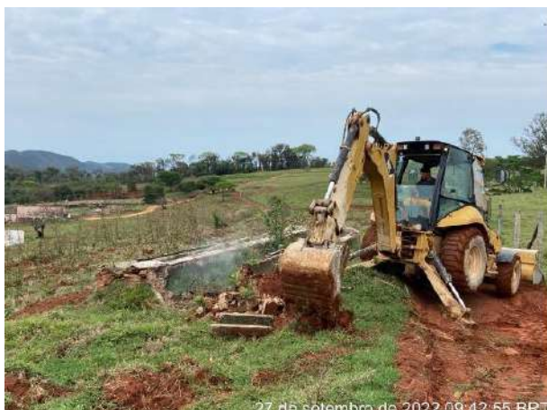
Foto 13 – Início da demolição. (Foto: 27/09/2022)
