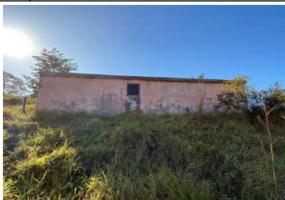
Foto 2 - Vista da estrutura
