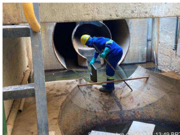
Foto 16 – Retirada de material contaminado de dentro usina. (Data: 08/09/2022)
